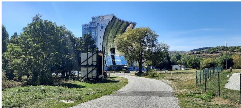
**Le four solaire d'Odeillo, de 50 mètres de haut, 60 de large et 30 de profondeur, comprenant 63 héliostats (dispositif permettant de suivre la course du Soleil, généralement pour orienter toute la journée les rayons solaires vers un point ou une petite surface fixe, à l'aide de miroirs), est un four fonctionnant à l'énergie solaire, mis en service en 1969.**
